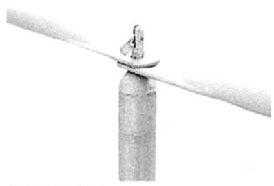
テスリ取付部
