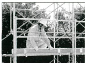
2. 布板の厚さにあわせてロック金具を調整します。
