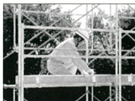
3. 2カ所の締め付けボルトでロック金具を布板にしっかり固定します。
